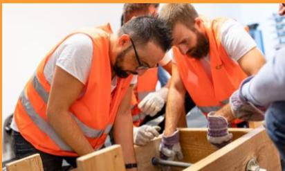
Für die Erstellung einer Betonwand gehört die Schalung inkl. Armierung zu den wichtigsten Utensilien. Die Masse wird hineingegossen und härtet dort aus, damit sie die endgültige Form behält. Die Aufgabe des Teams lautet, eine solche Schalung in möglichst kurzer Zeit und fehlerfrei zu erstellen.
